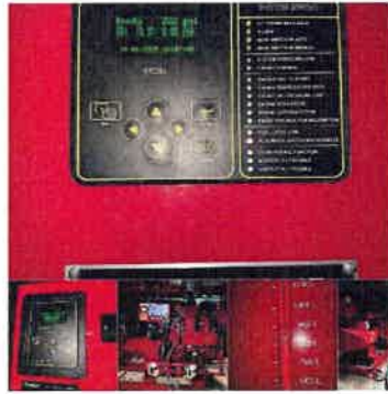
วันที่ 18/05/2567 เวลา 15:30 น. สถานีเครื่อง Pump ขึ้น 1 Transfer pump no.1,2 = 146 psi Booster pump no.1,2,3 = 45 psi Water Level = 90 % Fire pump = 222 psi Jockey pump = 222 psi Fuel Tank = 828 L สถานะเครื่องอัตโนมัติ
