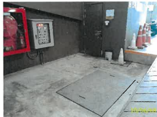
ตู้ควบคุม และบ่อรวบรวมน้ำเสียห้องพักขยะรวม
