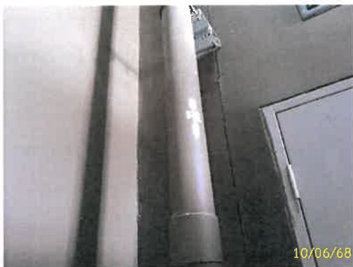
ท่อระบายน้ำชั้นหลังคา
