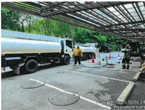
ตัดไขมัน และสูบลบคอนระบบบำบัดน้ำเสีย
