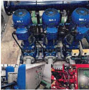
วันที่ 24/05/2568 เวลา 22:47 น. สถานีเครื่อง Pump ขึ้น 1 Booster pump No.1,2,3 = 12 psi Booster pump No.1,2,3 = 48 psi Water Level Tank = 100 % Fire Pump = 102 psi Jockey Pump = 102 psi Fuel Tank = 200 L สถานะเครื่องอัตโนมัติ
