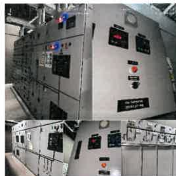
วันที่ 28/06/2568 เวลา 06:30 น. ตรวจสอบเครื่อง MDB ขึ้น 3 สาขาทันตกรรม PM 101 ขึ้น 3 สาขาทันตกรรม (ขึ้น) ปกติ MDB 1 สถานะ On Auto MDB 2 สถานะ On Auto TR 1 Selector Auto ถูกกด 57/01/014 TR 2 Selector Auto ถูกกด 59/01/012 ATS 2 สถานะ Auto CAP 1 สถานะ Auto CAP 2 สถานะ Auto
