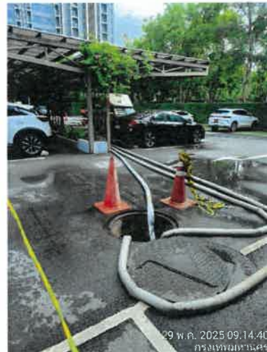
ตัดไขมัน และสูบลบคอนระบบบำบัดน้ำเสีย
