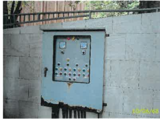
ตู้ควบคุมบ่อสุดท้ายก่อนปล่อยออก
