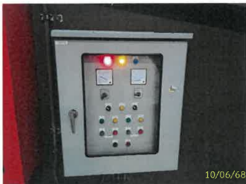
ตู้ควบคุม และบ่อรวบรวมน้ำเสียห้องพักขยะรวม
