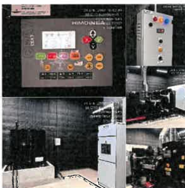
วันที่ 24/06/2568 เวลา 16:42 น. ตรวจสอบเครื่อง Generator ขึ้น 5 สาขาทันตกรรม สถานะ Auto Fuel Tank = 700 L
