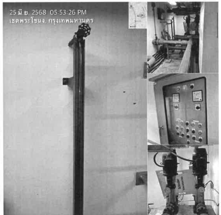
วันที่ 25/06/2568 เวลา 17:53 น. ตรวจเช็คห้อง Pump ชั้น 30 Transfer pump no.3 = 110 psi Transfer pump no.4 = 110 psi สวิตช์อยู่ในสถานะ Auto Water Level = 70 %
